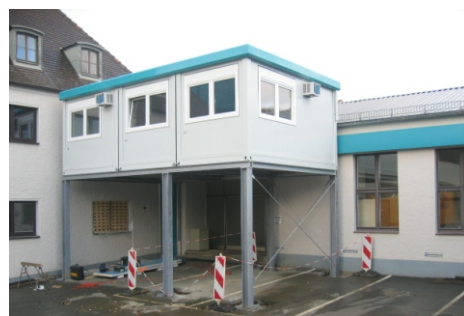
Anlage auf Stelzen mit umlaufender Attika
