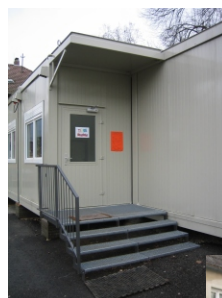
Vordächer, Treppenaufgänge mit Geländer
